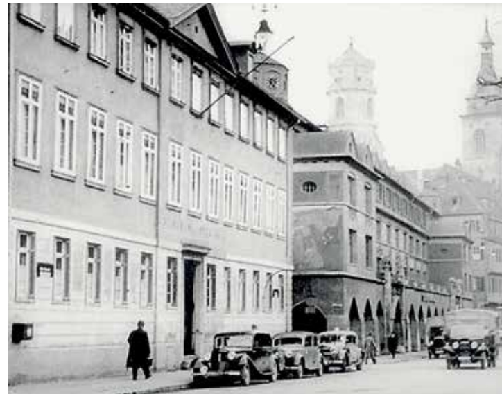
Württembergisches Innenministerium am Karlsplatz in Stuttgart der 1930er Jahre / Württemberg Ministry of the Interior at Karlsplatz in Stuttgart during the 1930s
